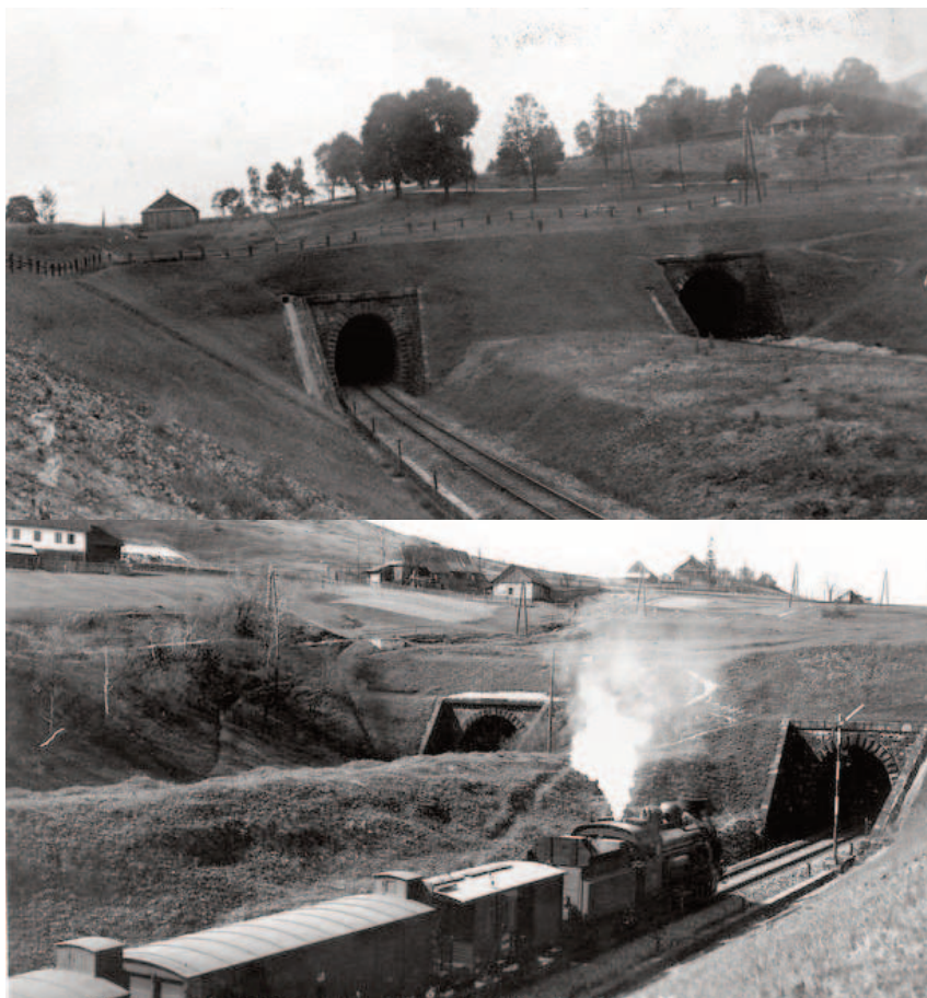
Jablunkovský tunel sa pred vypuknutím druhej svetovej vojny dostal do zvýšenej pozornosti nemeckej spravodajskej služby
